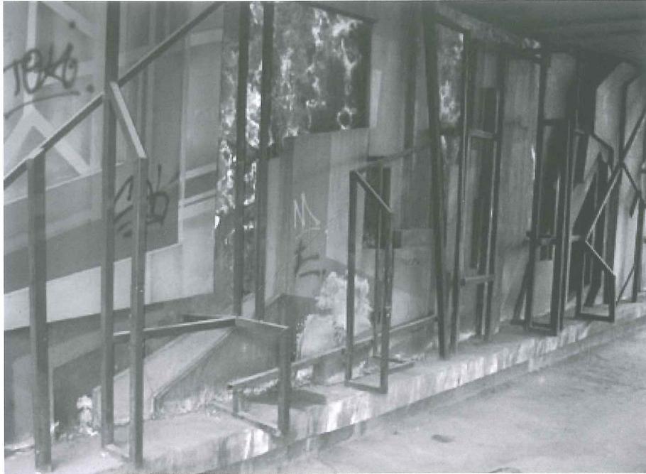
*Escultura pública situado bajo el paso elevado de Nuevos Ministerios. Se puede apreciar claramente en la imagen el deterioro producido por corrosión, degradación y vandalismo.*
