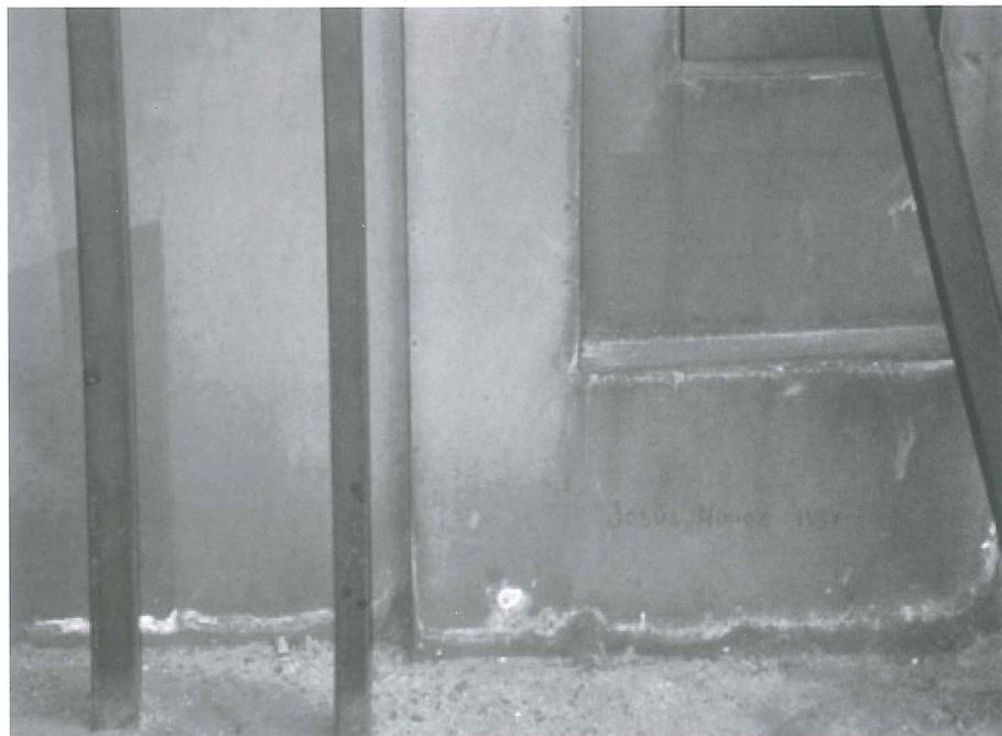
*Imagen macro de detalle de la zona inferior derecha donde se aprecia la oxidación y emanaciones salinas.*
